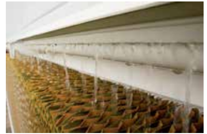
Özel tasarım su yansıtıcı, pet panelin tüm yüzeyine eşit miktarda su dağıtılmasını sağlar.
